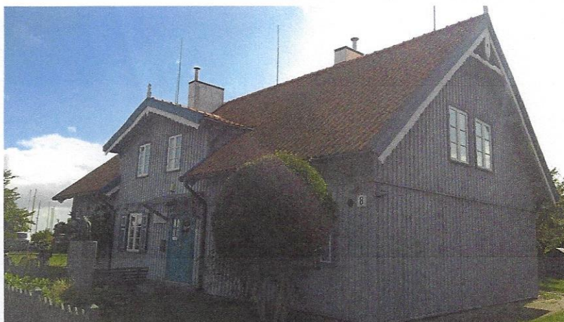
FF-01 Pastato fasadų vaizdas iš šiaurės vakarų pusės.
