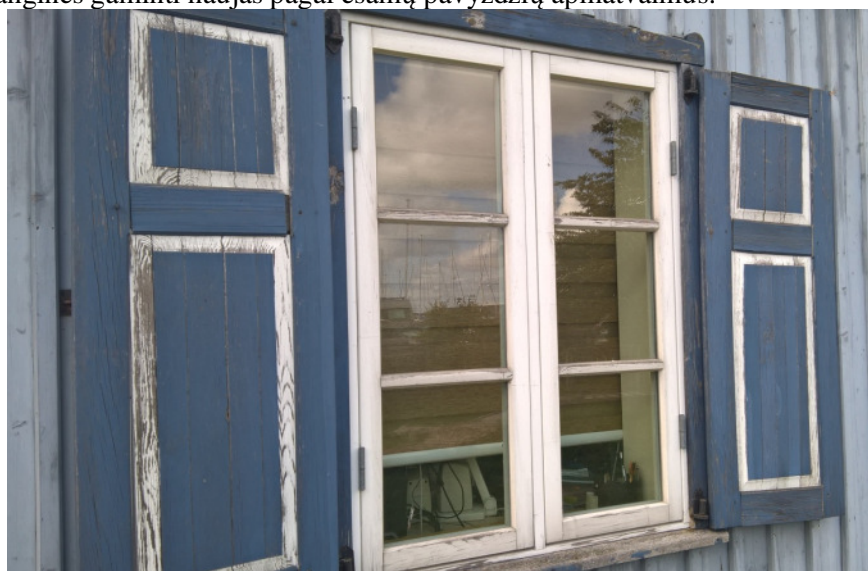
FF-22. Pirmo aukšto langas su langinėmis. Bendras vaizdas.
